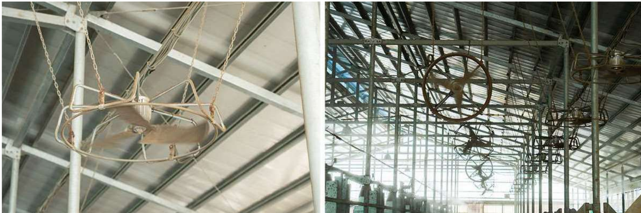
牛舎内に設置された扇風機で定期的にミストを噴射して拡散させている
